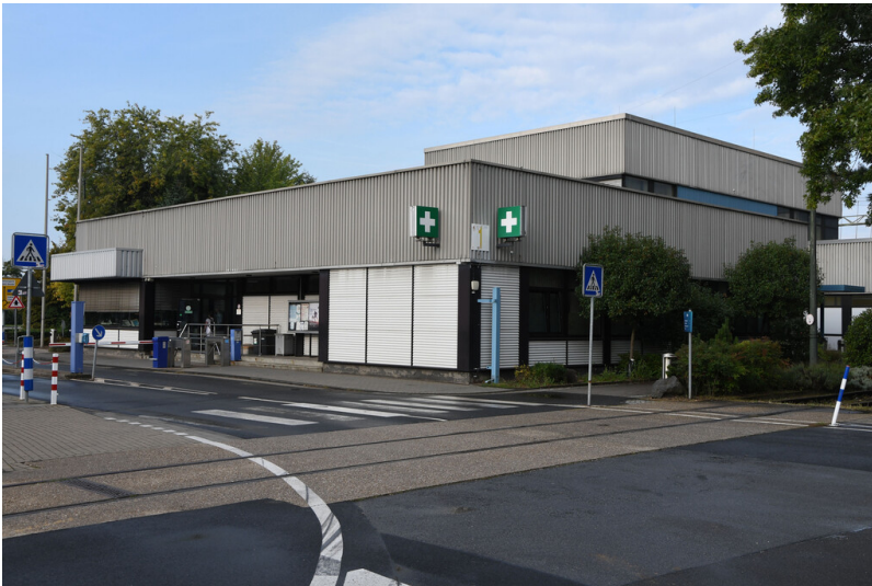
Kraftwerk Neurath: Eingangsgebäude, Ansicht von Nordosten; Foto: 12.09.2023 Fotograf/Urheber: Dr. Norbert Gilson
