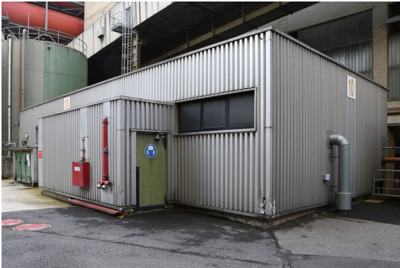
Kraftwerk Neurath: Zündölpumpenhaus, Ansicht von Nordwesten; Foto: 12.09.2023 Fotograf/Urheber: Dr. Norbert Gilson
