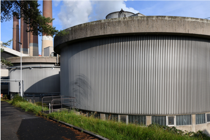
Kraftwerk Neurath: Schlammeindicker 1 (hinten) und 2 (vorne), Ansicht von Südosten; Foto: 12.09.2023 Fotograf/Urheber: Dr. Norbert Gilson
