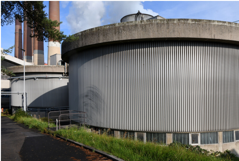
Kraftwerk Neurath: Schlammeindicker 1 (hinten) und 2 (vorne), Ansicht von Südosten; Foto: 12.09.2023 Fotograf/Urheber: Dr. Norbert Gilson
