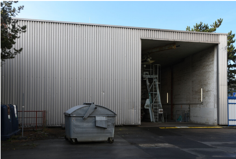
Kraftwerk Neurath: Pumpenhaus, automatische Rechenanlage, Ansicht von Nordosten; Foto: 12.09.2023 Fotograf/Urheber: Dr. Norbert Gilson
