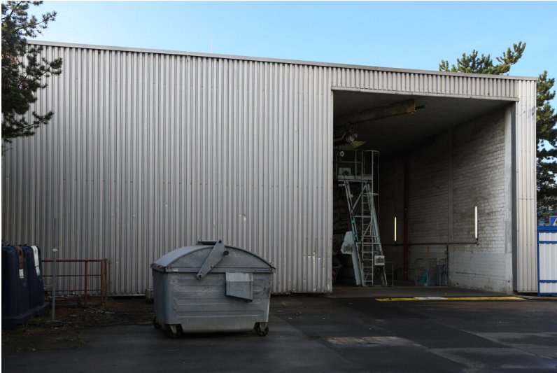
Kraftwerk Neurath: Pumpenhaus, automatische Rechenanlage, Ansicht von Nordosten; Foto: 12.09.2023 Fotograf/Urheber: Dr. Norbert Gilson
