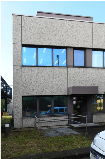
Kraftwerk Neurath: TC-Labor, Ansicht von Nordosten; Foto: 12.09.2023 Fotograf/Urheber: Dr. Norbert Gilson
