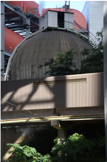
Kraftwerk Neurath: Reinkondensatspeicher für die Blöcke D/E, Ansicht von Süden; Foto: 12.09.2023 Fotograf/Urheber: Dr. Norbert Gilson
