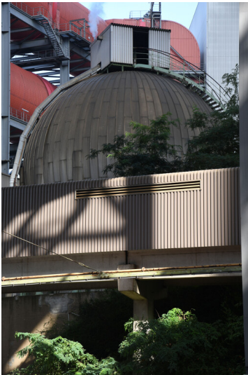
Kraftwerk Neurath: Reinkondensatspeicher für die Blöcke D/E, Ansicht von Süden; Foto: 12.09.2023 Fotograf/Urheber: Dr. Norbert Gilson
