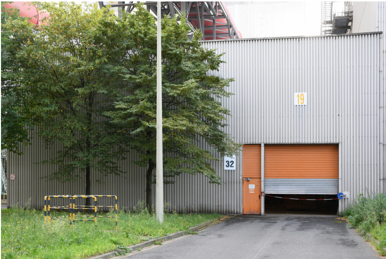
Kraftwerk Neurath: Kondensatreinigung D/E, Ansicht von Norden; Foto: 12.09.2023 Fotograf/Urheber: Dr. Norbert Gilson
