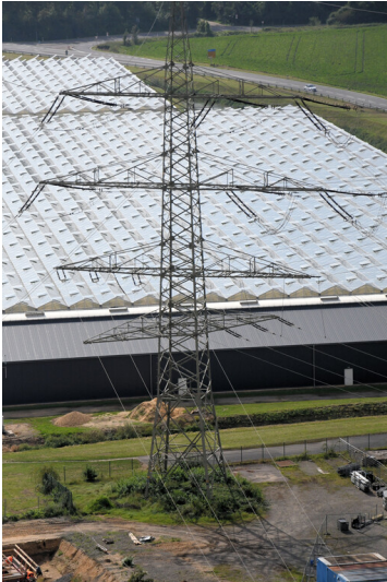
Kraftwerk Neurath: Abspannmast 1 (Bl-Nr. 4585) mit Aufnahme der Leitungsseile der Hochspannungsleitung "Neurath 1a", Ansicht von Nordosten; Foto: 14.09.2023 Fotograf/Urheber: Dr. Norbert Gilson
