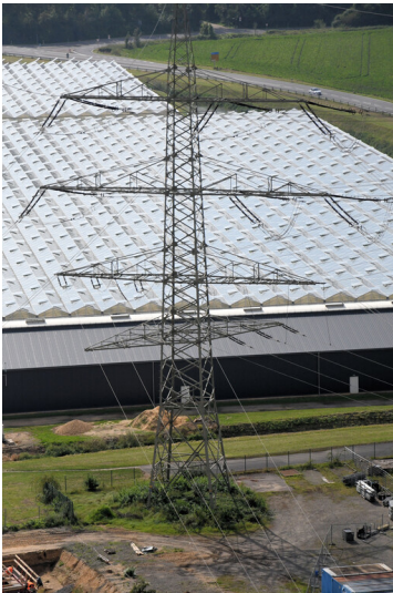
Kraftwerk Neurath: Freileitungsabgang Blöcke B/C, Führung der Leiterseile zum Leitungsabgang "Neurath 2b" auf Abspannmast M 1, Ansicht von Nordosten (Dach von Kesselhaus A); Foto: 14.09.2023 Fotograf/Urheber: Dr. Norbert Gilson
