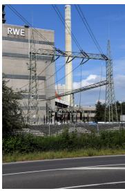
Kraftwerk Neurath: Freiluft-Schaltanlage Block A, Abspannportal und abgehende Leitungsseile, Ansicht von Nordwesten; Foto: 12.09.2023 Fotograf/Urheber: Dr. Norbert Gilson
