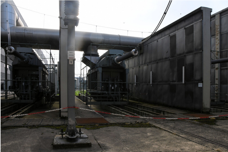
Kraftwerk Neurath: Maschinentransformatorpol (21/420 kV, 267 MVA), Phase V (Mitte) und U von Block D, Ansicht von Westen; Foto: 14.09.2023 Fotograf/Urheber: Dr. Norbert Gilson
