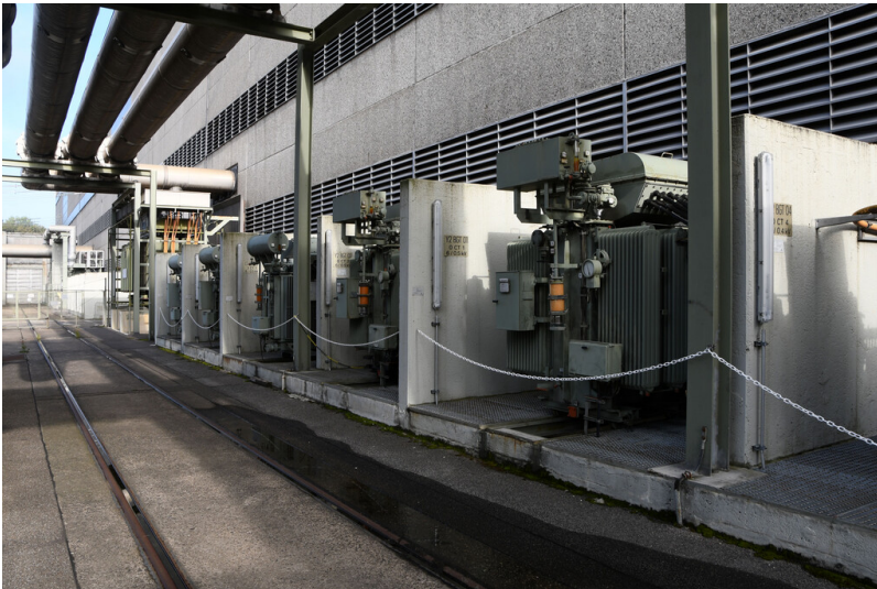
Kraftwerk Neurath: Haustransformatoren Block C, Ansicht von Südosten; Foto: 14.09.2023 Fotograf/Urheber: Dr. Norbert Gilson
