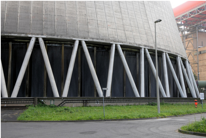
Kraftwerk Neurath: Kühlturm Block E, Kühlturmtasse und Schrägstreben, Ansicht von Osten; Foto: 12.09.2023 Fotograf/Urheber: Dr. Norbert Gilson
