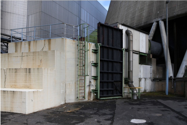
Kraftwerk Neurath: Kühlturm Block D, Kühlwassereinlauf und -auslauf, Ansicht von Südosten; Foto: 12.09.2023 Fotograf/Urheber: Dr. Norbert Gilson
