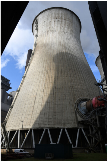
Kraftwerk Neurath: Kühlturm Block C, Ansicht von Osten; Foto: 12.09.2023 Fotograf/Urheber: Dr. Norbert Gilson
