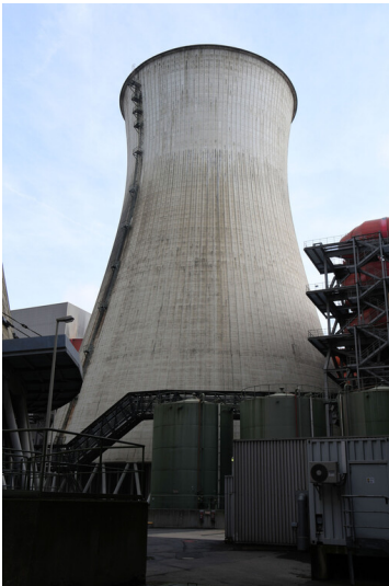
Kraftwerk Neurath: Kühlturm Block A, Ansicht von Westen; Foto: 12.09.20233 Fotograf/Urheber: Dr. Norbert Gilson
