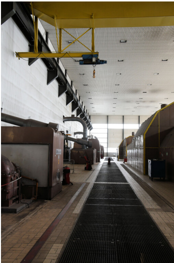
Kraftwerk Neurath: Maschinenhaus C, Zwischenbauseite, Innenansicht von Westen aus Höhe Block C; Foto: 14.09.2023 Fotograf/Urheber: Dr. Norbert Gilson
