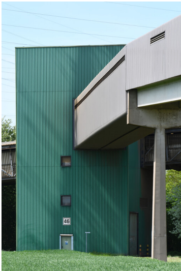
Kraftwerk Neurath: Übergabebauwerk 4, Ansicht von Osten, Einführung der Bandbrücke vom Kraftwerk Neurath; Foto: 04.05.2023 Fotograf/Urheber: Dr. Norbert Gilson
