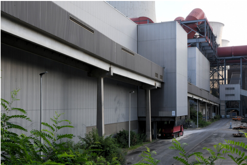
Kraftwerk Neurath: Asche-Fernband, Verlauf entlang des Gipslagers, Ansicht von Westen; Foto: 12.09.2023 Fotograf/Urheber: Dr. Norbert Gilson
