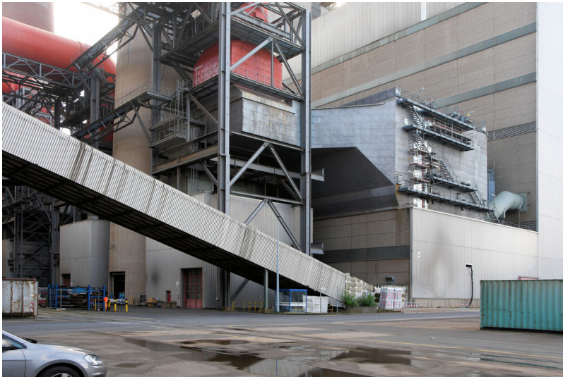
Kraftwerk Neurath: Entschungsweg Blöcke A/E, Schrägbandbrücke von der Nassentäschung der Blöcke D und E, Ansicht von Nordwesten; Foto: 12.09.2023 Fotograf/Urheber: Dr. Norbert Gilson
