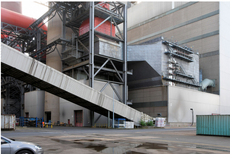
Kraftwerk Neurath: Entaschungsweg Blöcke A/E, Schrägbandbrücke von der Nassentaschung der Blöcke D und E, Ansicht von Nordwesten; Foto: 12.09.2023 Fotograf/Urheber: Dr. Norbert Gilson
