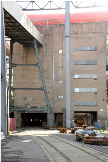
Kraftwerk Neurath: Asche-Waggonverladung (Notentaschung für die Blöcke D/E) auf Ebene +0 m im Nassaschebunker D/E (links), Ansicht von Westen; Foto: 12.09.2023 Fotograf/Urheber: Dr. Norbert Gilson
