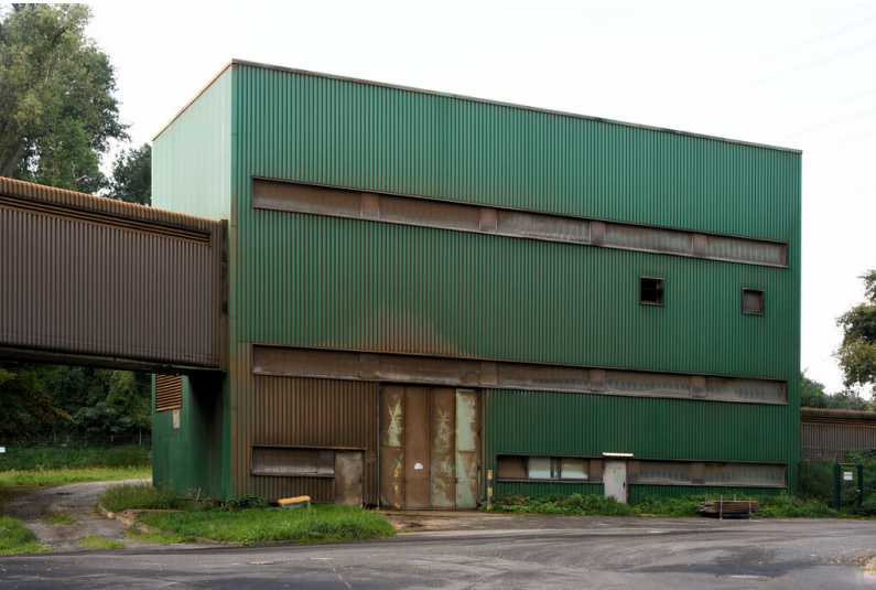
Kraftwerk Neurath: Übergabebauwerk 2, Ansicht von Nordosten; Foto: 12.09.2023 Fotograf/Urheber: Dr. Norbert Gilson
