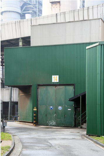
Kraftwerk Neurath: Übergabebauwerk 1, Ansicht von Norden; Foto: 12.09.2023 Fotograf/Urheber: Dr. Norbert Gilson
