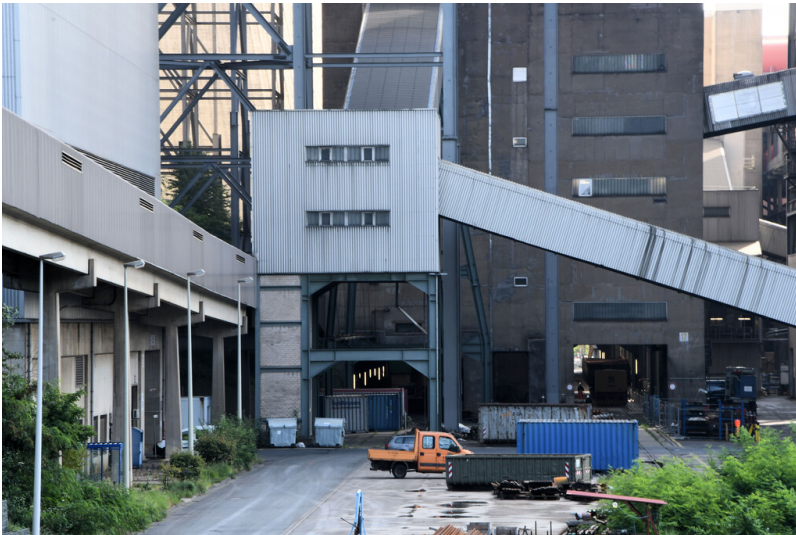
Kraftwerk Neurath: Ascheeckturn E, zuführende und abgehende Aschebandbrücken, Ansicht von Westen; Foto: 12.09.2023 Fotograf/Urheber: Dr. Norbert Gilson
