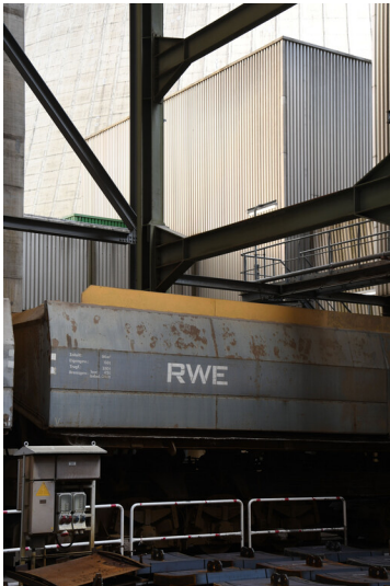
Kraftwerk Neurath: Ascheeckturn D/E, Ansicht von Südwesten; Foto: 12.09.2023 Fotograf/Urheber: Dr. Norbert Gilson
