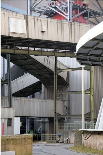
Kraftwerk Neurath: Ascheeckturn A/C, Ansicht von Osten; Foto: 12.09.2023 Fotograf/Urheber: Dr. Norbert Gilson
