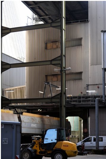
Kraftwerk Neurath: Ascheturm A/C, Ansicht von Westen; Foto: 12.09.2023 Fotograf/Urheber: Dr. Norbert Gilson
