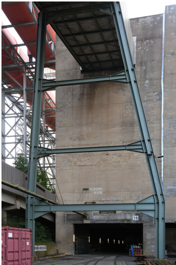
Kraftwerk Neurath: Aschebunker D/E, Bunkerteil für Nassasche, Ansicht von Westen; Foto: 12.09.2023 Fotograf/Urheber: Dr. Norbert Gilson
