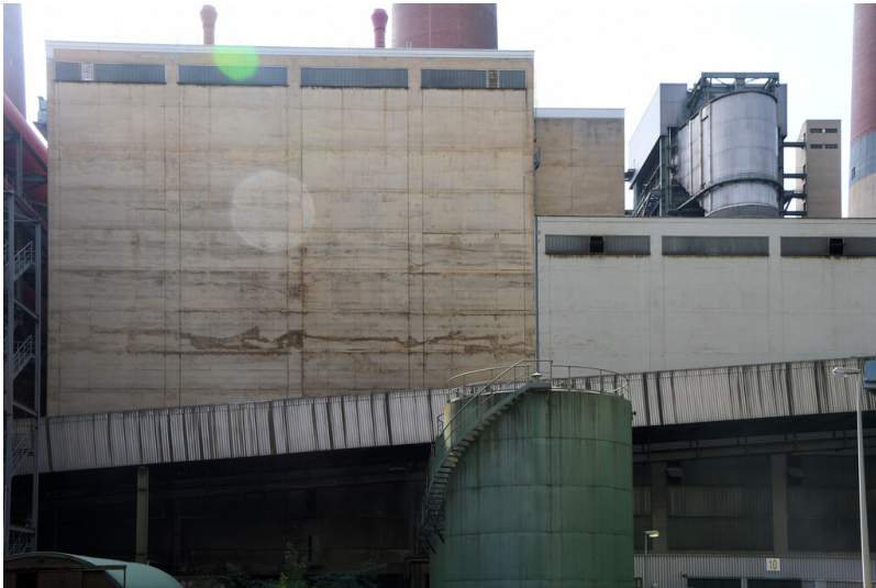
Kraftwerk Neurath: Aschebunker A/B/C, Bunkerteil für Nassasche (rechts) und für Flugasche (links), Ansicht von Norden; Foto: 12.09.2023 Fotograf/Urheber: Dr. Norbert Gilson
