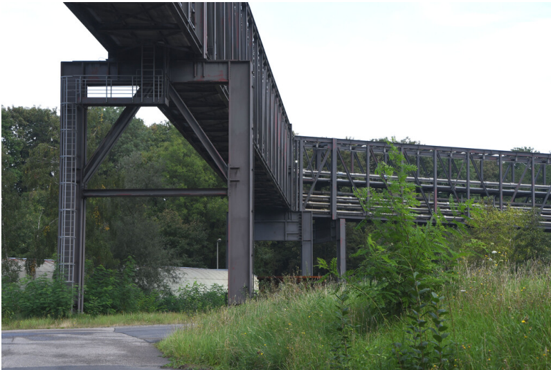
Kraftwerk Neurath: Rohrbrücke zur Führung der Gipsförderleitungen vor dem Gipsentwässerungsgebäude, Ansicht von Süden; Foto: 12.09.2023 Fotograf/Urheber: Dr. Norbert Gilson
