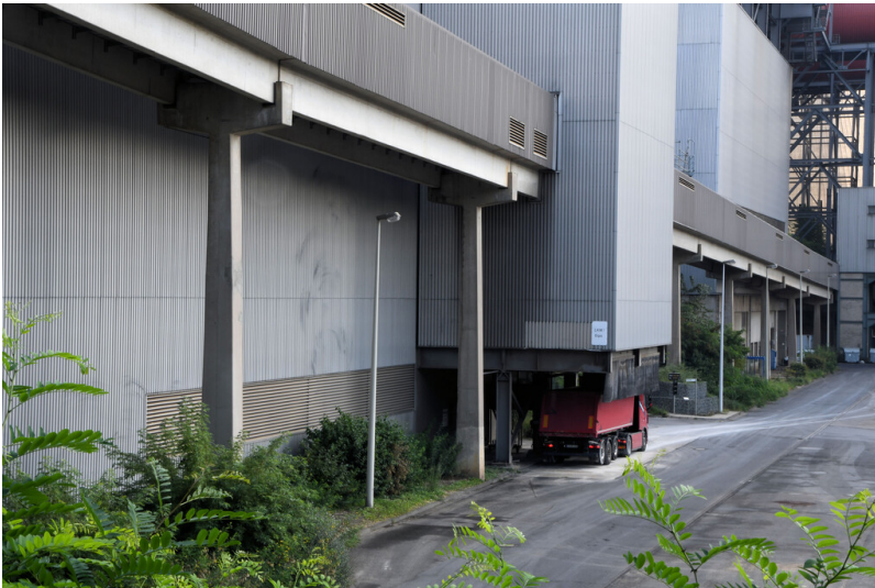
Kraftwerk Neurath: Gipslager, Lkw-Beladung, Ansicht von Westen; Foto: 12.09.2023 Fotograf/Urheber: Dr. Norbert Gilson
