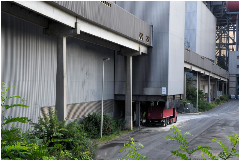
Kraftwerk Neurath: Gipslager, Lkw-Beladung, Ansicht von Westen; Foto: 12.09.2023 Fotograf/Urheber: Dr. Norbert Gilson
