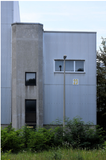
Kraftwerk Neurath: Schaltanlage Gipsbehandlung, Nordfassade und Treppenhausturm, Ansicht von Norden; Foto: 12.09.2023 Fotograf/Urheber: Dr. Norbert Gilson
