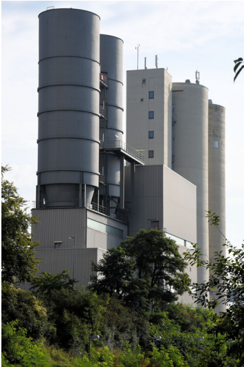
Kraftwerk Neurath: Kalk-Anlage mit den Kalksilos, Ansicht von Südwesten; Foto: 12.09.2023 Fotograf/Urheber: Dr. Norbert Gilson
