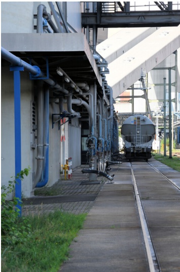
Kraftwerk Neurath: Kalkbahnhof, Ansicht von Osten; Foto: 12.09.2023 Fotograf/Urheber: Dr. Norbert Gilson
