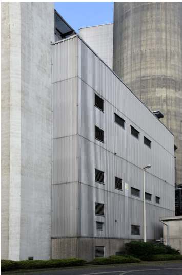
Kraftwerk Neurath: REA-Schaltanlage D/E, Ansicht von Südosten; Foto: 12.09.2023 Fotograf/Urheber: Dr. Norbert Gilson
