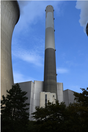
Kraftwerk Neurath: REA-Kamin D/E, Ansicht von Südosten; Foto: 12.09.2023 Fotograf/Urheber: Dr. Norbert Gilson
