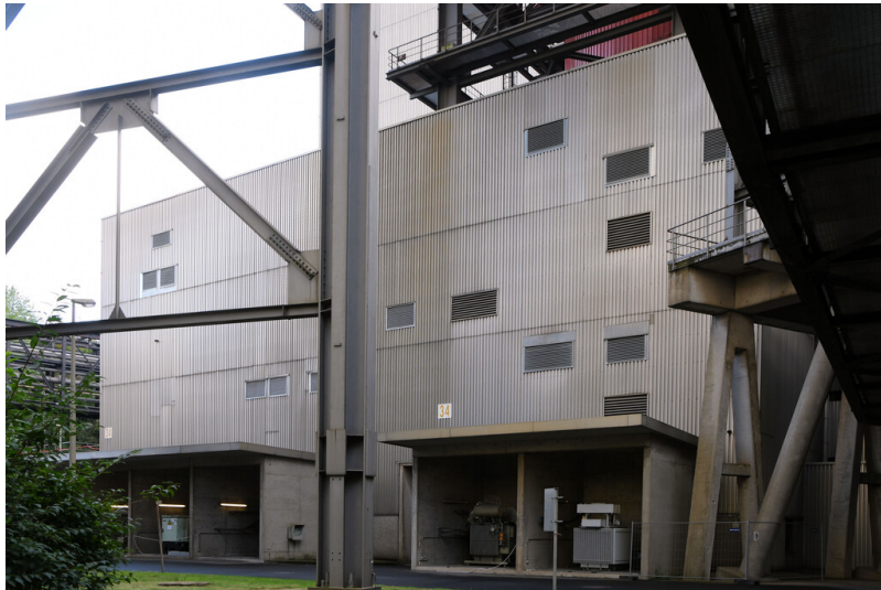
Kraftwerk Neurath: REA-Schaltanlage A/C, Ansicht von Westen; Foto: 12.09.2023 Fotograf/Urheber: Dr. Norbert Gilson
