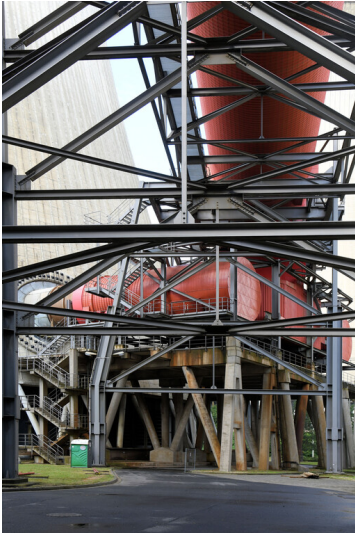
Kraftwerk Neurath: Reingaseinleitung Kühlturm C, Führung des Reingaskanals zum Kühlturm, Ansicht von Osten; Foto: 12.09.2023 Fotograf/Urheber: Dr. Norbert Gilson
