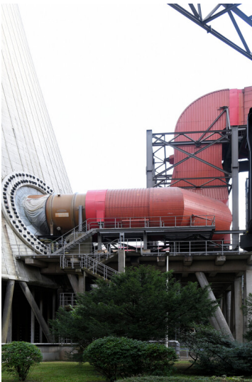
Kraftwerk Neurath: Reingaseinleitung Kühlturm B, Ansicht von Südwesten; Foto: 12.09.2023 Fotograf/Urheber: Dr. Norbert Gilson
