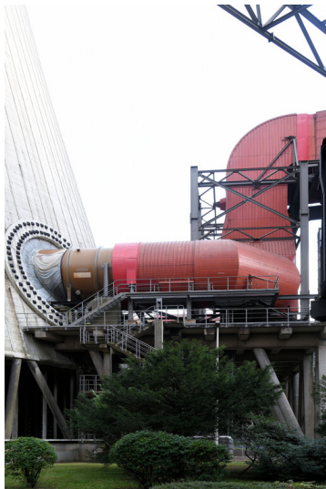
Kraftwerk Neurath: Reingaseinleitung Kühlturm B, Ansicht von Südwesten; Foto: 12.09.2023 Fotograf/Urheber: Dr. Norbert Gilson
