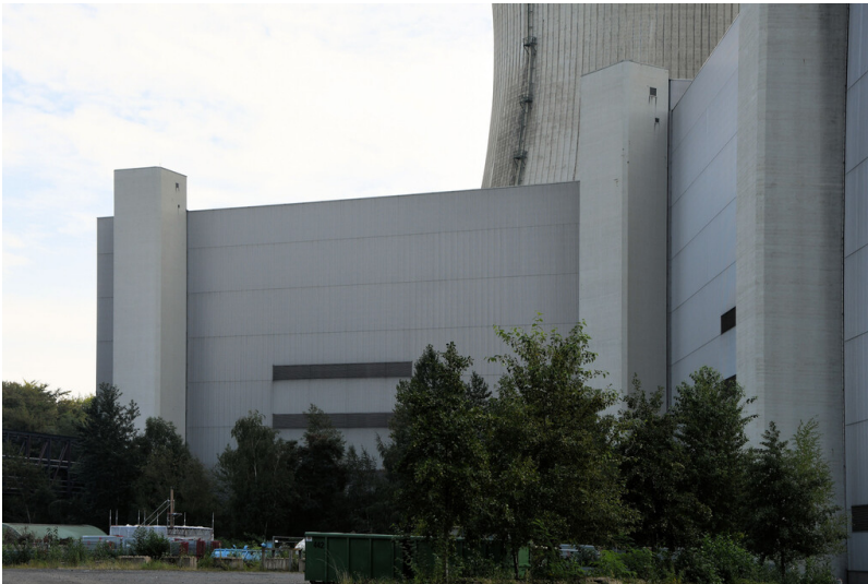
Kraftwerk Neurath: Absorbergebäude D, Ansicht von Westen; Foto: 12.09.2023 Fotograf/Urheber: Dr. Norbert Gilson
