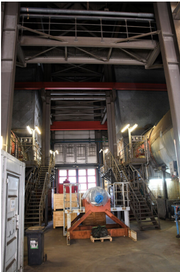
Kraftwerk Neurath: Absorbergebäude A/C, Details der Gebäudekonstruktion, Innenansicht; Foto: 12.09.2023 Fotograf/Urheber: Dr. Norbert Gilson
