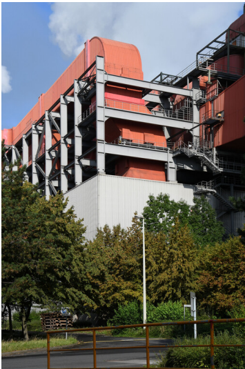
Kraftwerk Neurath: Saugzuggebläsehaus Blöcke A/C, Einführung der Rohgaskanäle, Ansicht von Südosten; Foto: 12.09.2023 Fotograf/Urheber: Dr. Norbert Gilson
