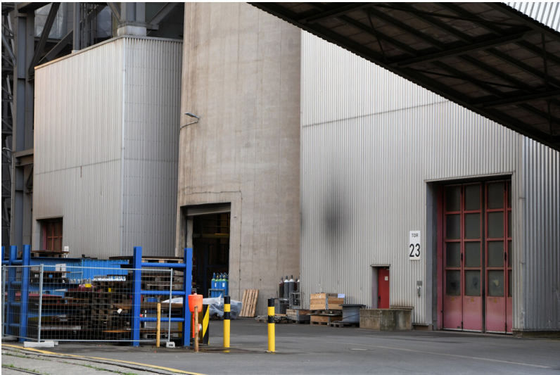
Kraftwerk Neurath: Schornstein Block E, Stahlbeton-Fundamentsockel mit Einfahrt, Ansicht von Nordwesten; Foto: 12.09.2023 Fotograf/Urheber: Dr. Norbert Gilson
