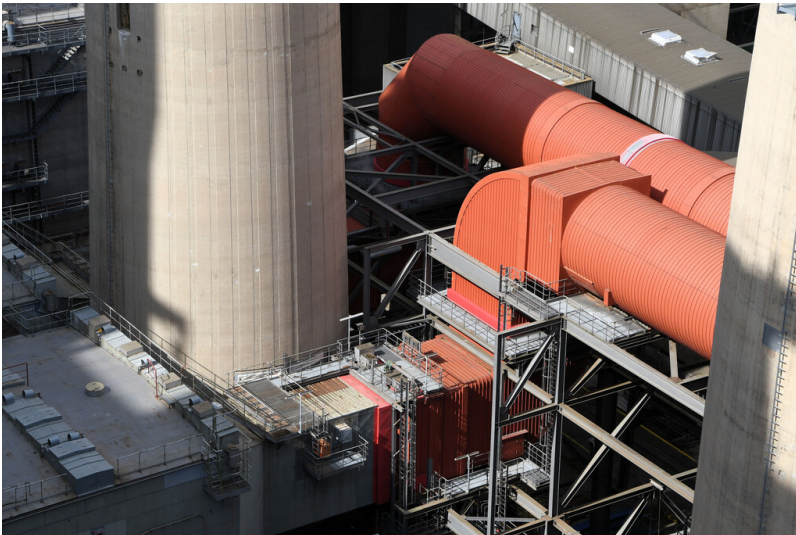
Kraftwerk Neurath: Elektrofilter Block C, Anschluss eines der Elektrofilter an den Rohgaskanal zum REA-Wäschergebäude, Ansicht von Südosten (vom Dach des Kesselhauses A); Foto: 14.09.2023 Fotograf/Urheber: Dr. Norbert Gilson
