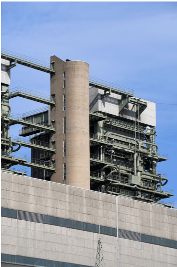
Kraftwerk Neurath: Kessel Block A, über den Zwischenbau hinausragend, Ansicht von Südwesten; Foto: 12.09.2023 Fotograf/Urheber: Dr. Norbert Gilson
