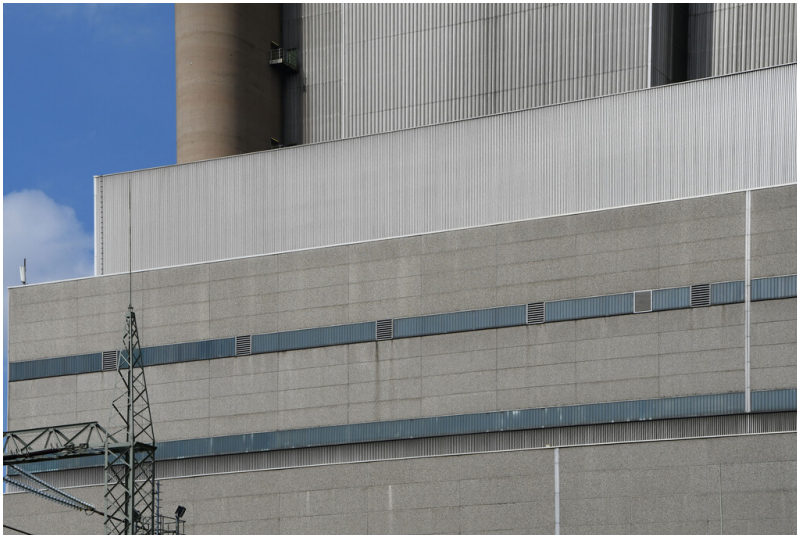
Kraftwerk Neurath: Zwischenbau Block E, Ansicht von Süden; Foto: 12.09.2023 Fotograf/Urheber: Dr. Norbert Gilson
